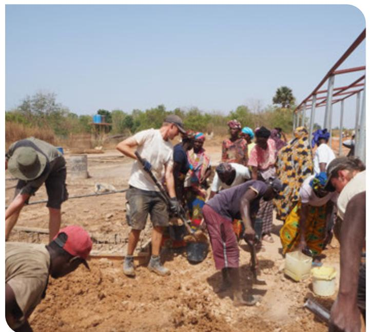
Der Aushub der Toilettengrube wird als Füllmaterial für Fundamente verwendet. (EWB, Saba 05/2024)
